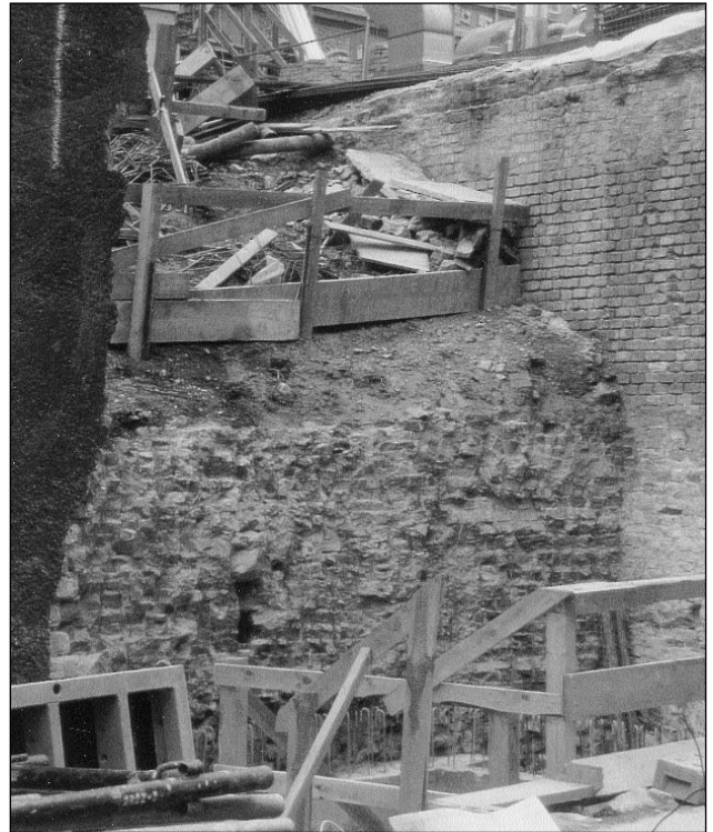
Bei den Restaurierungsarbeiten des Palais Coburg wurde dieses Stück der ehemaligen Braunbastion, später auch Coburgbastion genannt, freigelegt. Darunter befinden sich wie auch an anderen Plätzen noch die ehemaligen Kasematten der Stadtbefestigung (Photo Gr)
