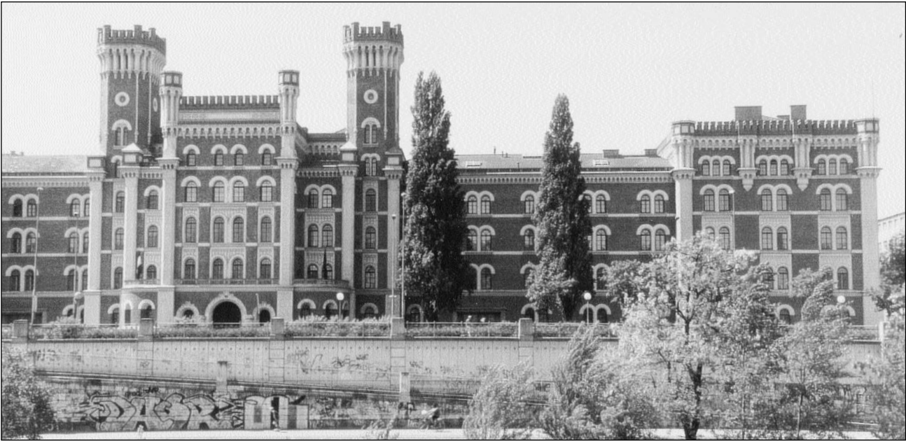
Die Rossauerkaserne in ihrem heutigen restaurierten Zustand (Photo Gr)
